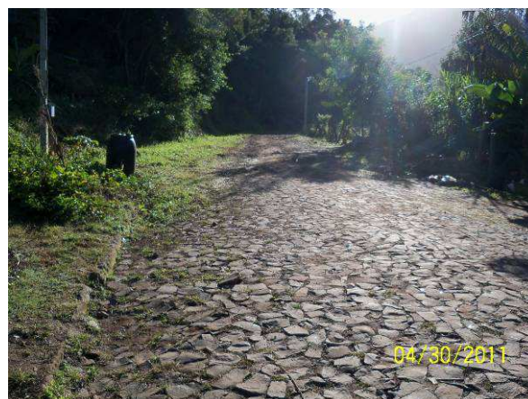
Vista do fim – capeamento
