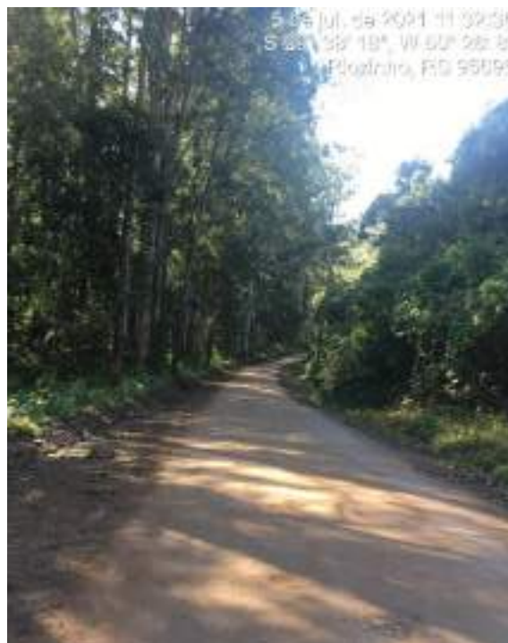
FOTO: Trecho a ser pavimentado
