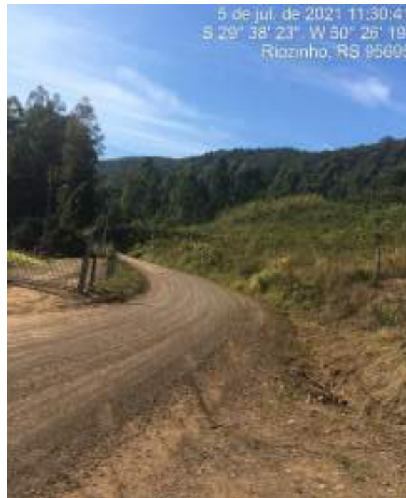
FOTO: Trecho a ser pavimentado
