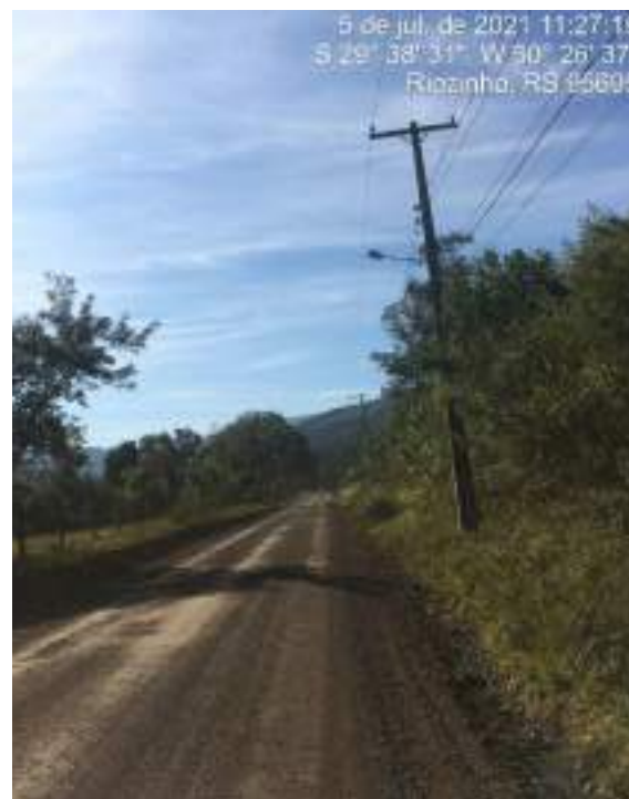
FOTO: Trecho a ser pavimentado
