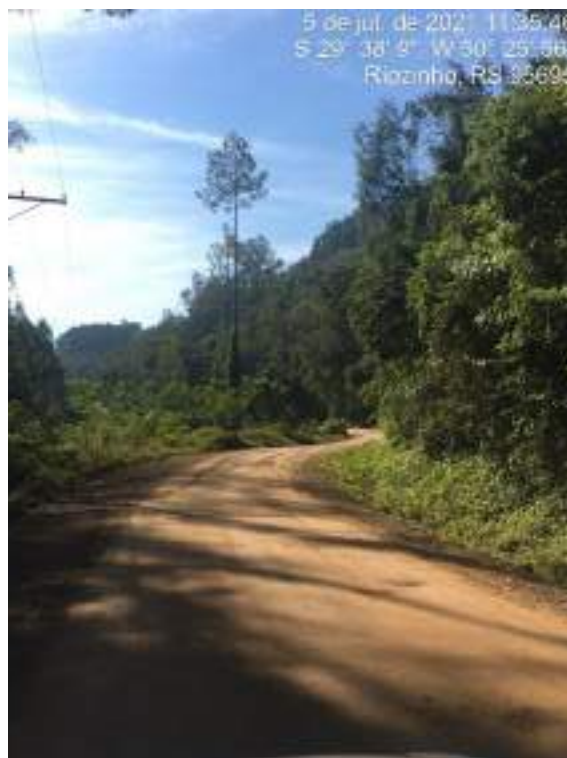
FOTO: Trecho a ser pavimentado
