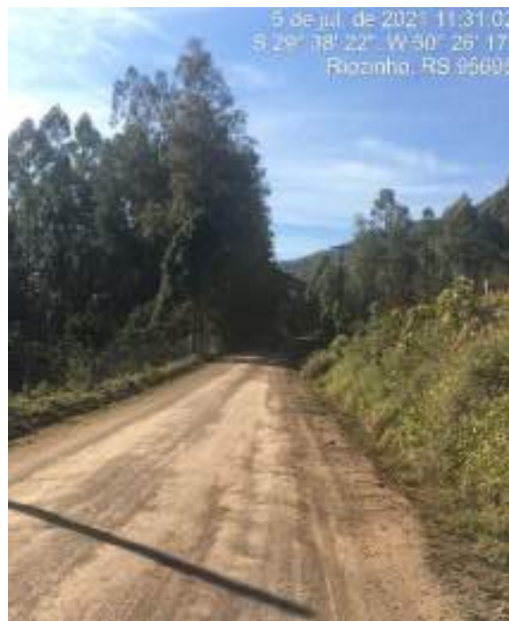
FOTO: Trecho a ser pavimentado
