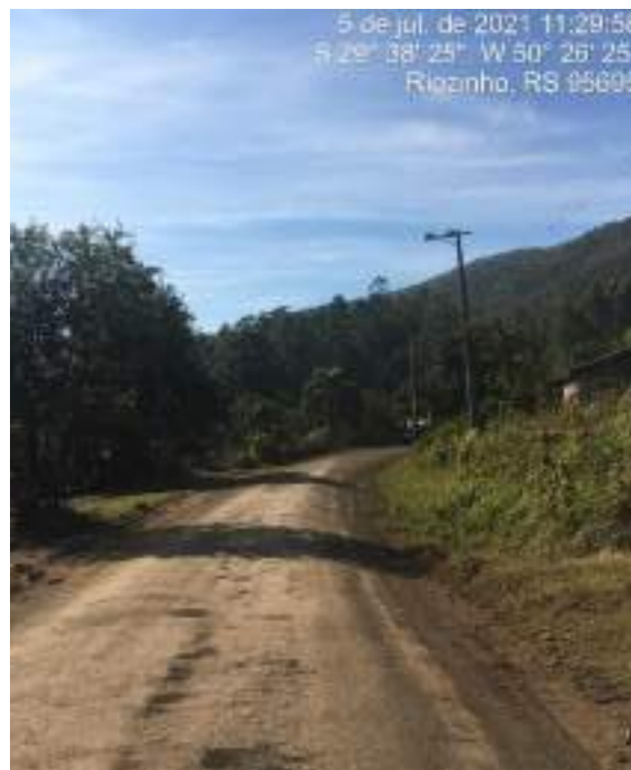
FOTO: Trecho a ser pavimentado
