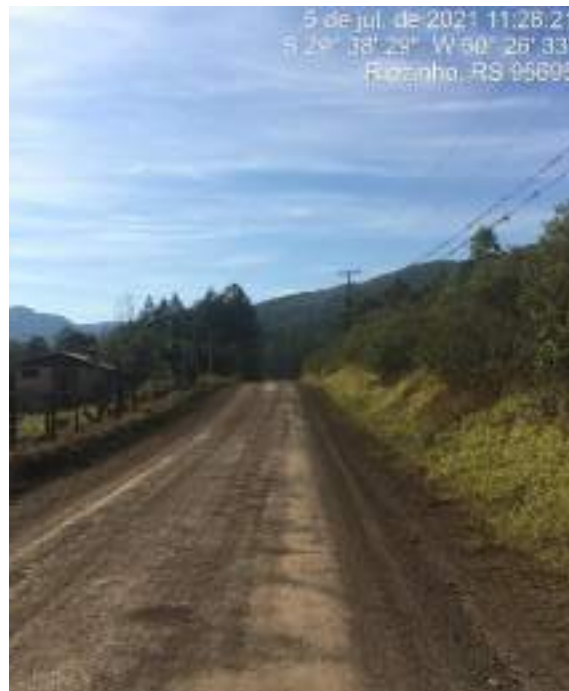
FOTO: Trecho a ser pavimentado
