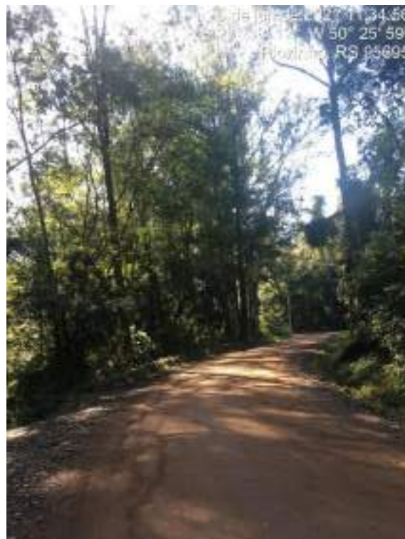
FOTO: Trecho a ser pavimentado
