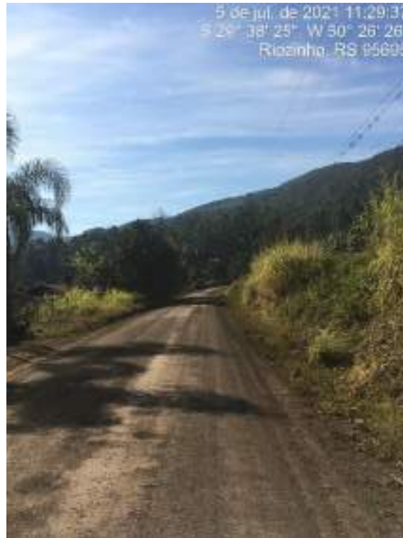
FOTO: Trecho a ser pavimentado
