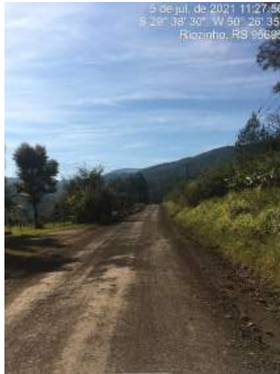
FOTO: Trecho a ser pavimentado
