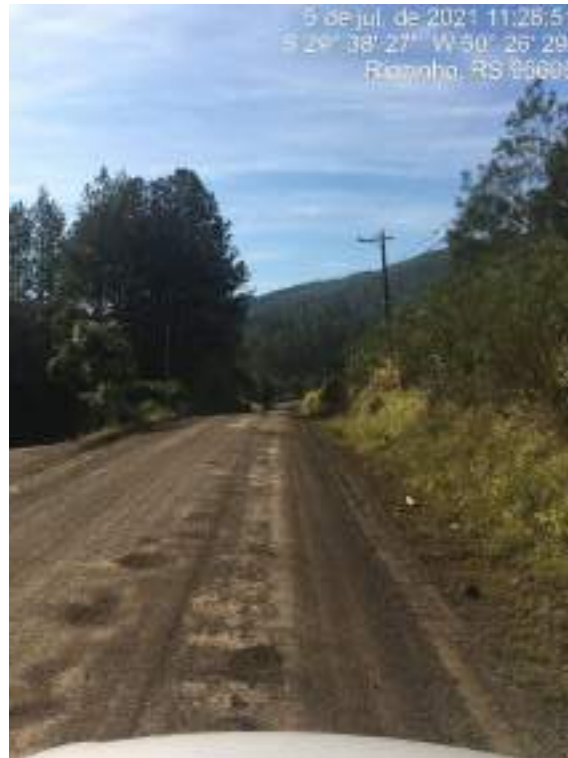
FOTO: Trecho a ser pavimentado
