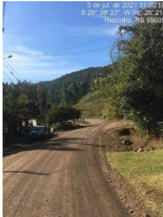
FOTO: Trecho a ser pavimentado
