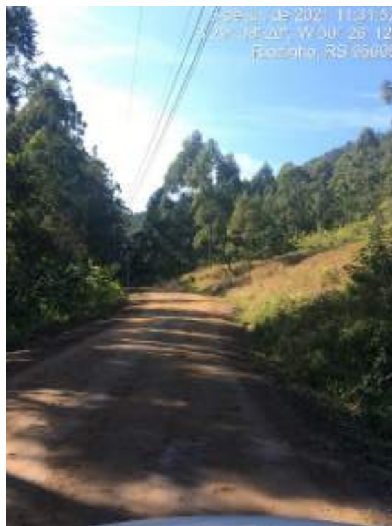
FOTO: Trecho a ser pavimentado
