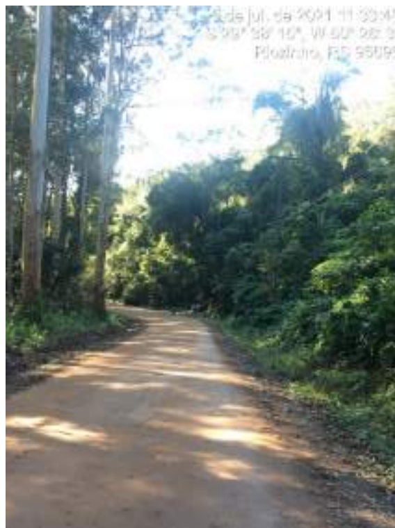
FOTO: Trecho a ser pavimentado
