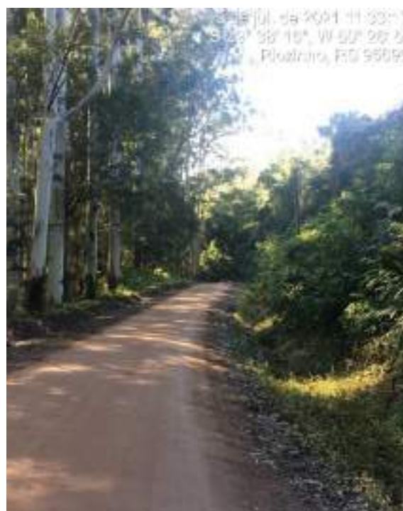
FOTO: Trecho a ser pavimentado
