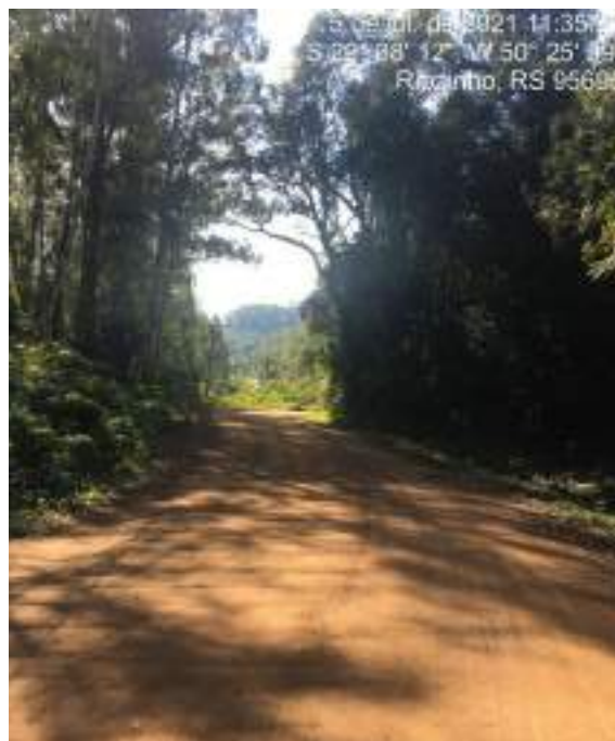
FOTO: Trecho a ser pavimentado
