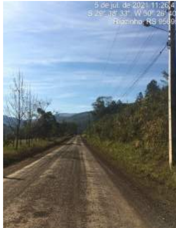
FOTO: Trecho a ser pavimentado
