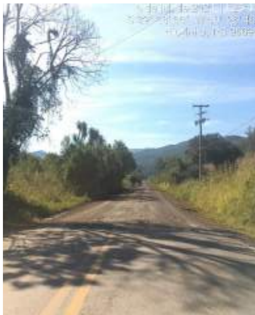
FOTO 01: Início do trecho a ser pavimentado
