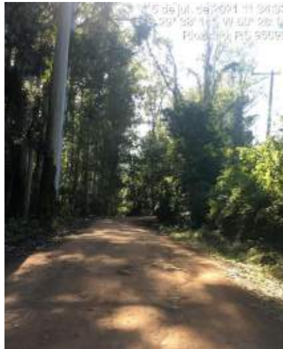
FOTO: Trecho a ser pavimentado
