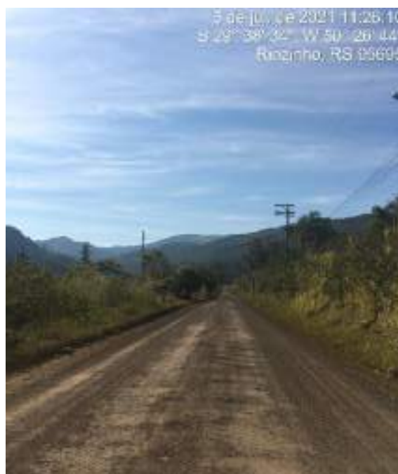
FOTO: Trecho a ser pavimentado
