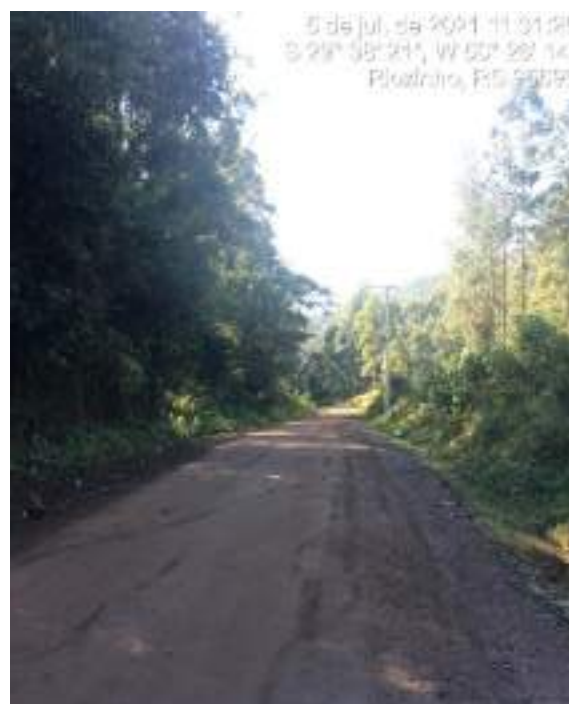
FOTO: Trecho a ser pavimentado
