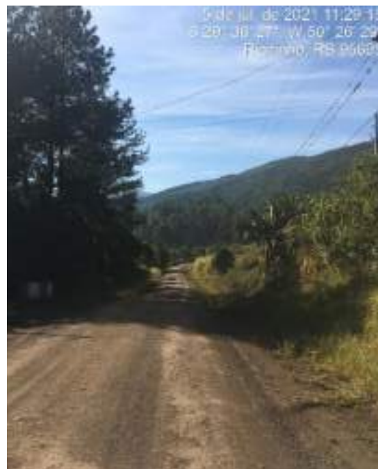
FOTO: Trecho a ser pavimentado
